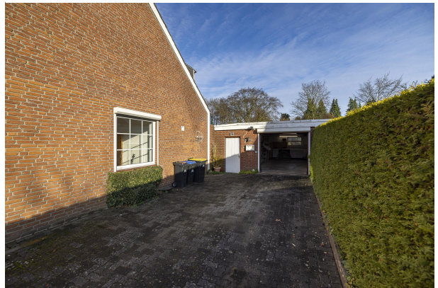
Auffahrt und Garage
