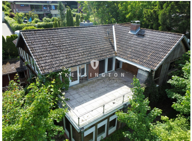
Hausansicht mit Terrasse
