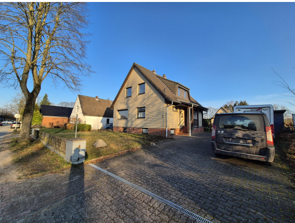
Hausansicht von der Straße aus
