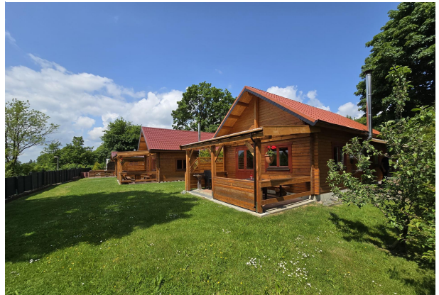
Terrassen der Blockhütten
