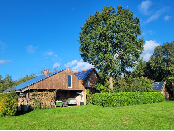
Remise von Norden
