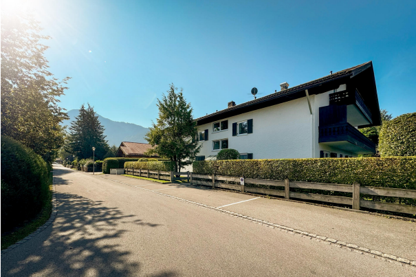
Hausansicht von der Straße aus
