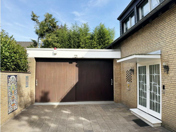
Frontansicht Haus Garage
