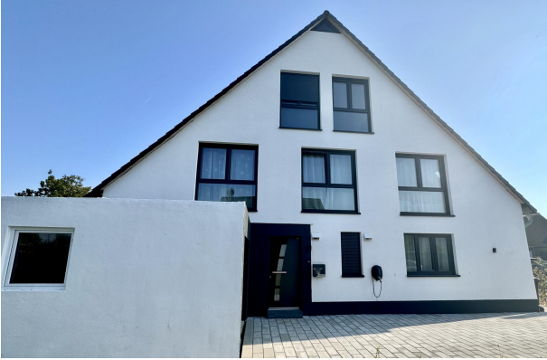
Giebelansicht Eingang Mastereinheit
