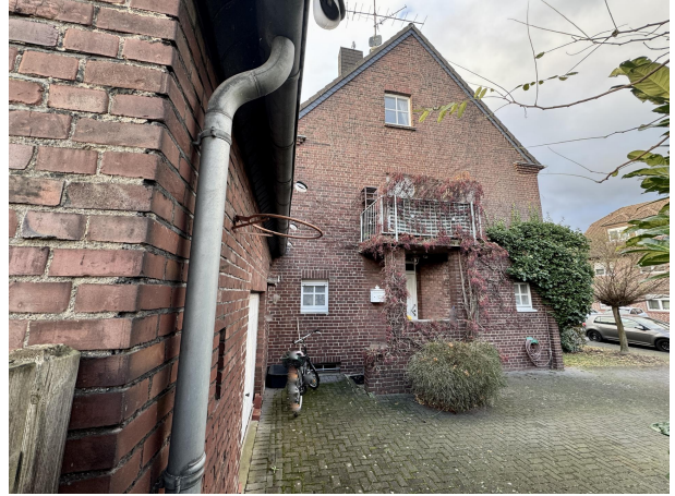
Giebel links Hauseingang mit Hof
