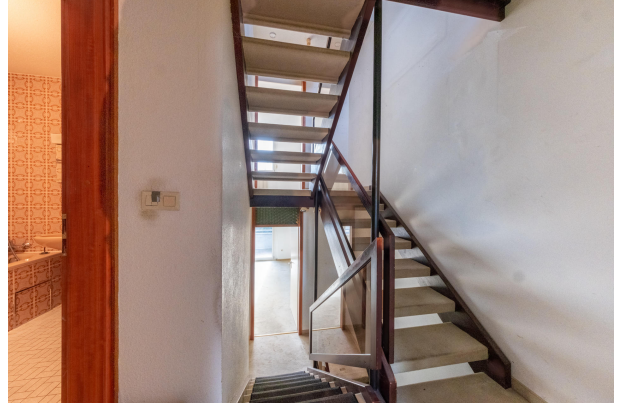
Treppe zum 1.OG
