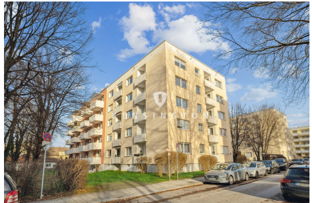
Aussenansicht auf die Balkone
