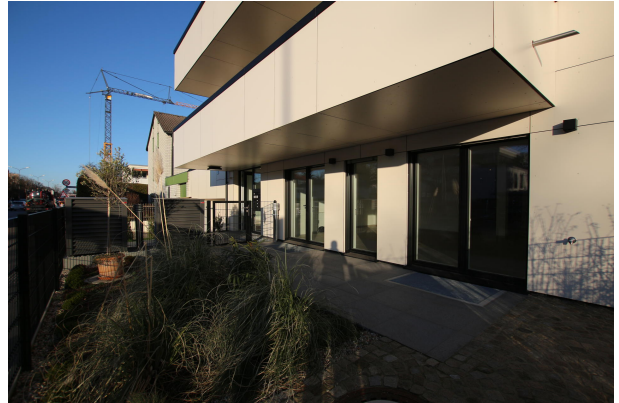
Terrasse zur Straße
