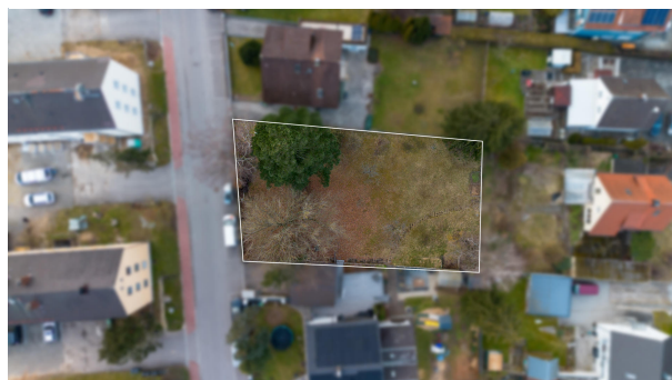
Grundstück Luftbild - Drohne
