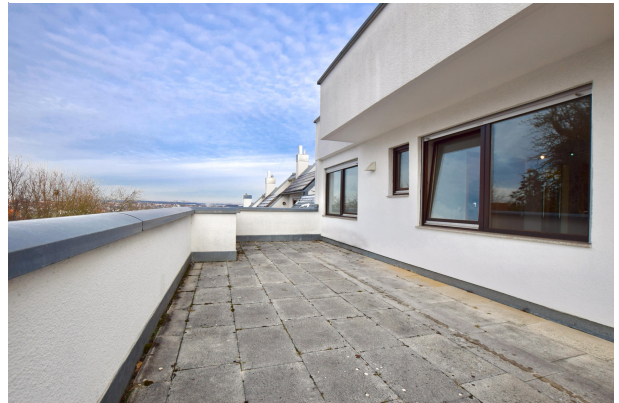
Balkon / Dachterrasse im 1. OG
