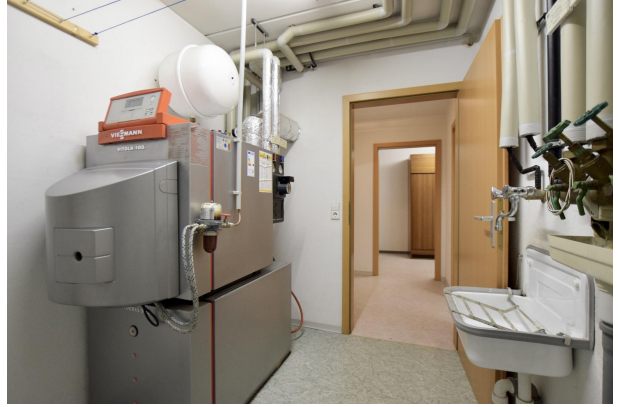
Heizungsraum / Öl-Zentralheizung
