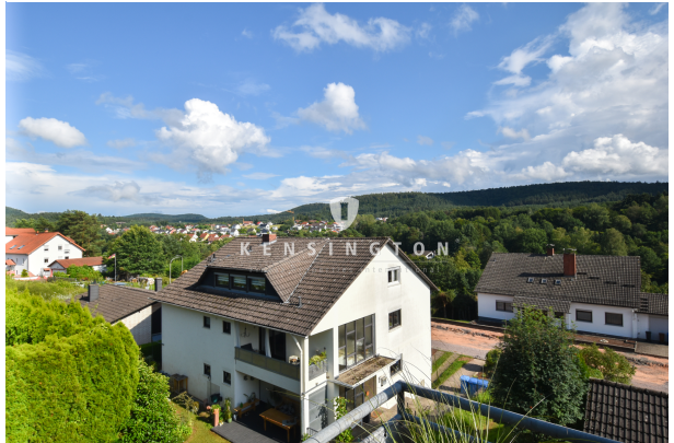
KSW418-Mehrfamilienhaus in Rodalben-1.OG links
