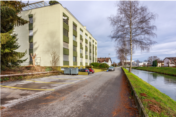
Aussenansicht MFH Birkenstrasse 73
