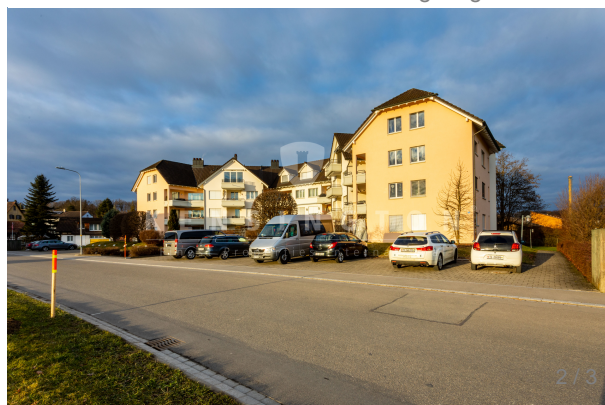
Strassenansicht 2.5 Zi-Gartenwohnung Istighofen
