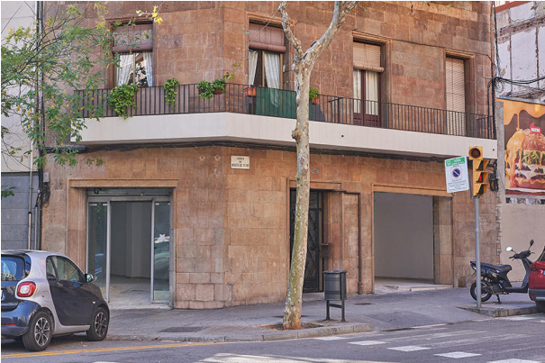
Fachada izquierda y derecha
