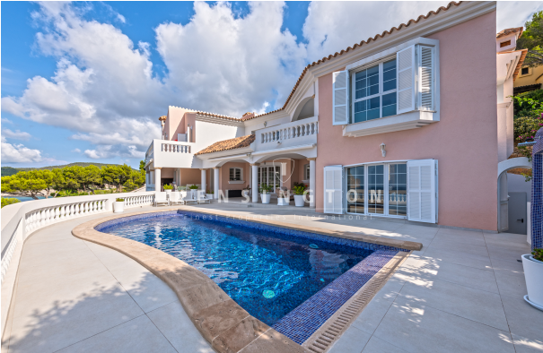
Villa en Camp de Mar piscina
