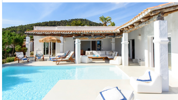
KPI1322 - Villa en venta - Villa zu verkaufen - Villa for sale - Villa te koop - www.kensington-ibiza.com - Noelle Politiek
